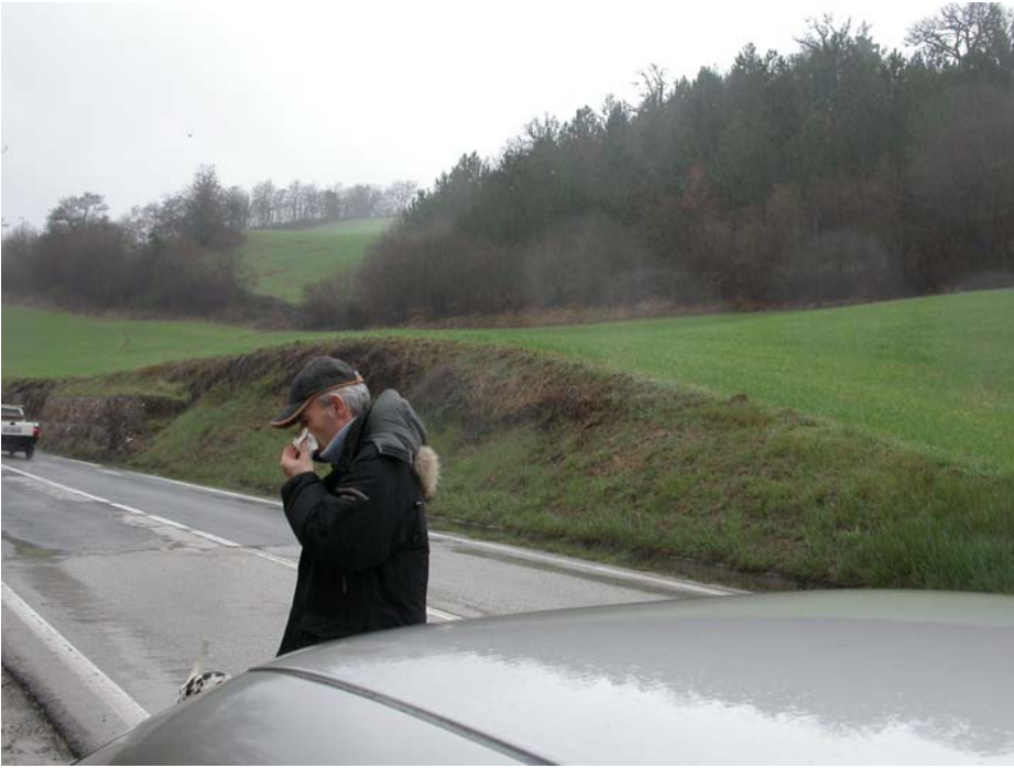
Punto di vista fotografico n. 4 . Depositi eluvio colluviali interessati da frana di tipo colamento quiescente
