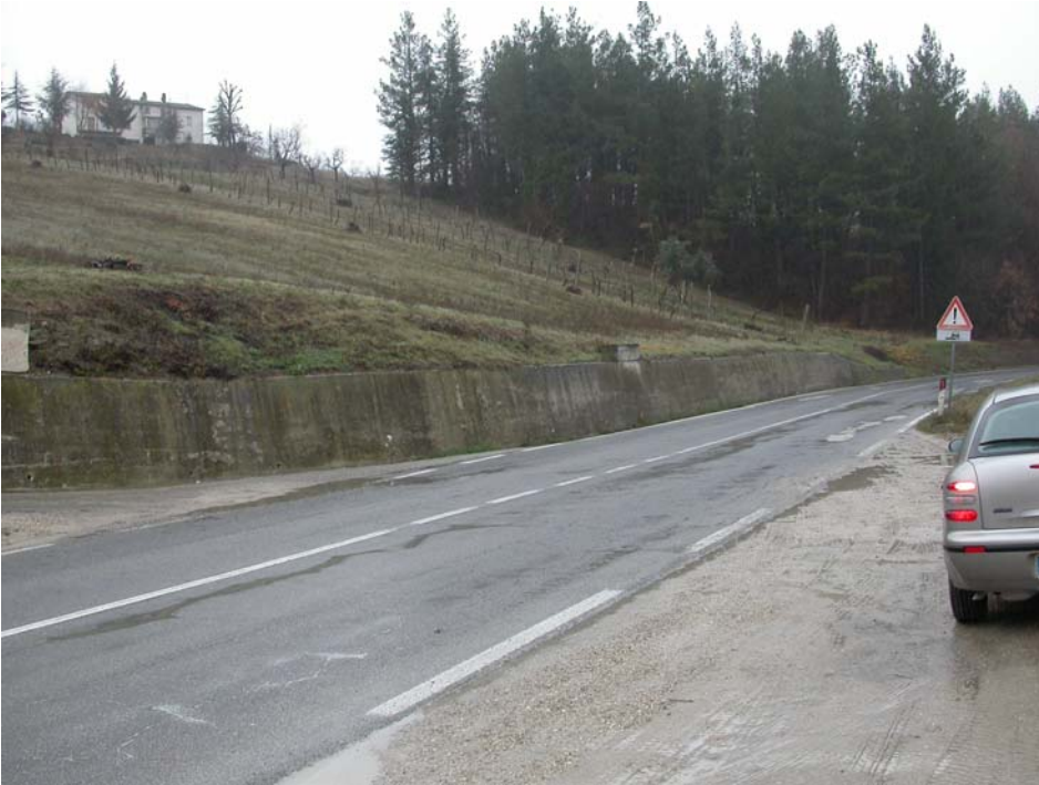
Punto di vista fotografico n. 2. Pendio interessato da forme di ruscellamento superficiale. Il muretto di contenimento a piede scarpa e l'attuale sede stradale sono in buono stato di equilibrio
